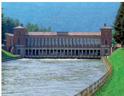
L'Edificio di Presa del Canale Cavour a Chivasso
